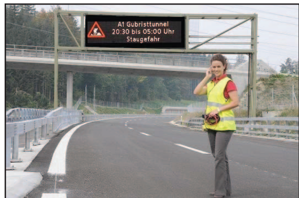
Anlagetests vor dem Gubristtunnel bei Zürich
